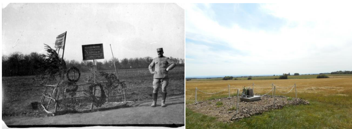
Sur l'emplacement même du crash de l'avion de Pégoud (1915 et 2015).
