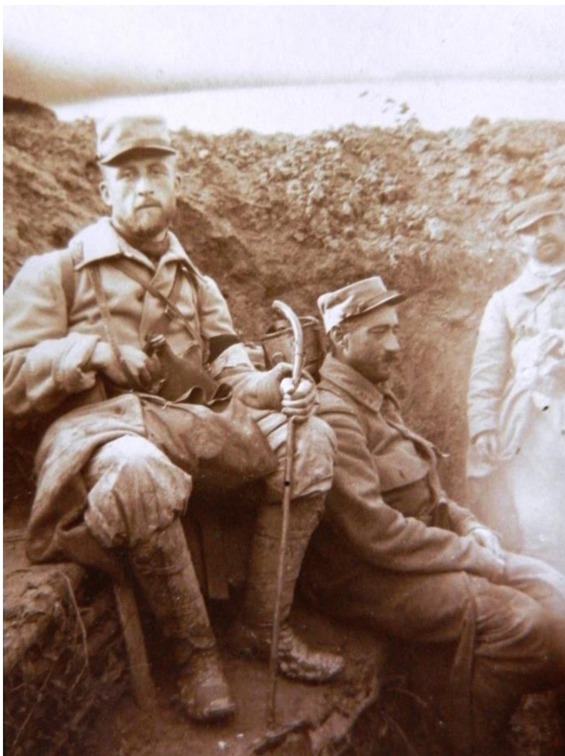
Tranchée des Saules.
