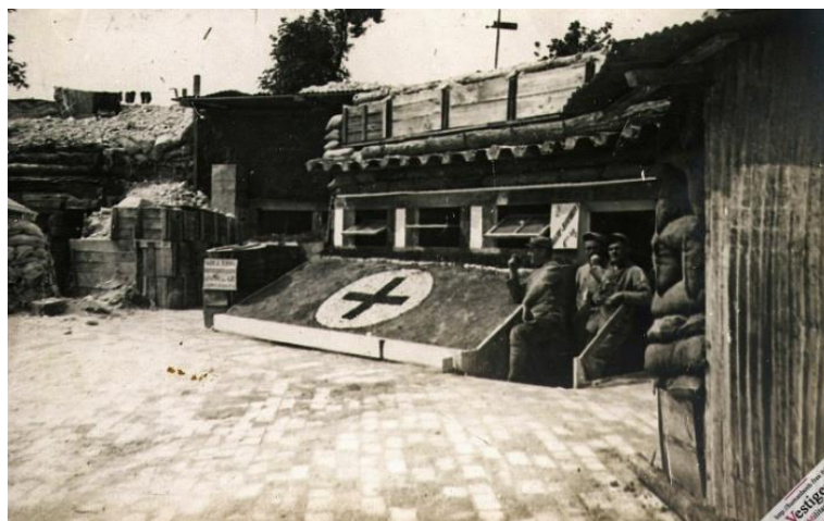
Postes de secours.
