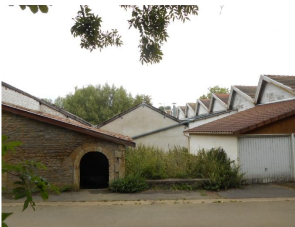
Les anciens bâtiments de l'usine.
